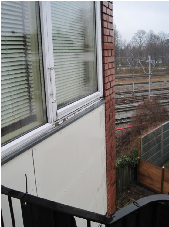
Vinduesparti på havesiden
