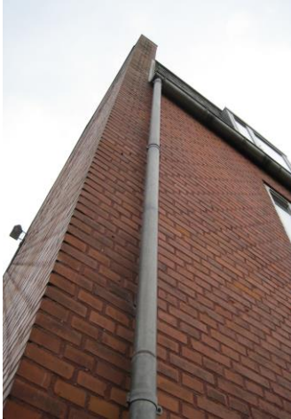
Facade ved nedløb
