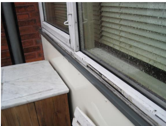
Vinduesparti på havesiden
