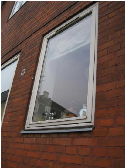
Vinduesparti på indgangssiden
